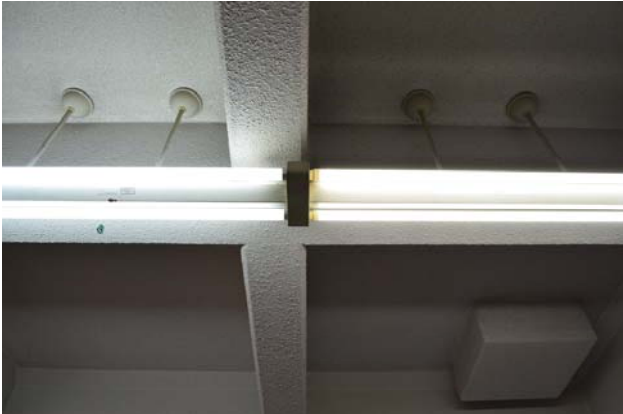
「左側旧蛍光灯 右側 LED 蛍光灯」
