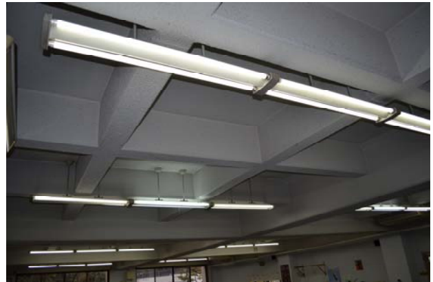
「交換工事終了後の照明」
