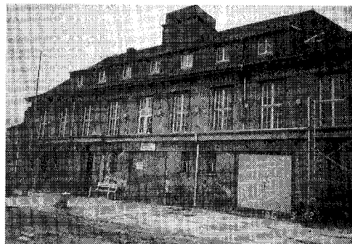
図-3 ボートクラブの裏側 (艇庫が1階で2階がレストラン)
